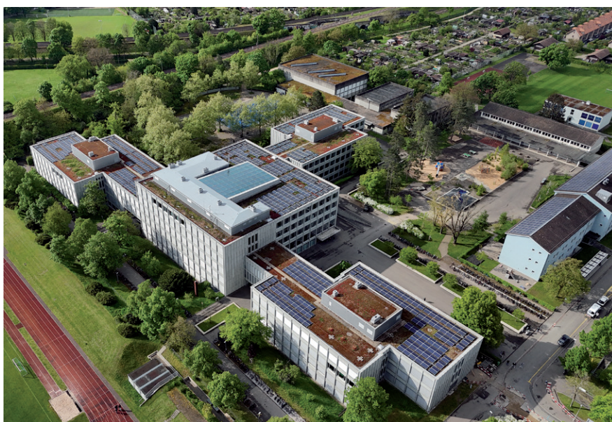
Foto: Gymnasium Bäumlhof Basel
